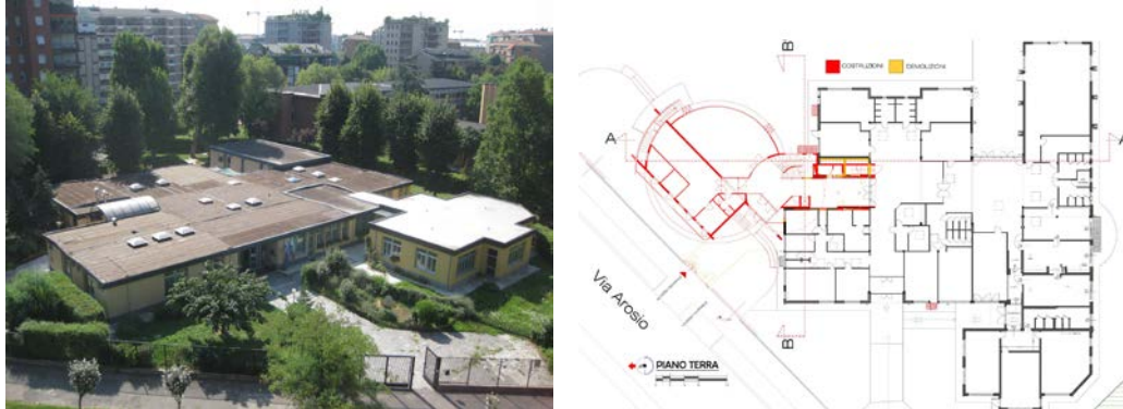
2007, Scuola Elementare Dezza di Melegnano, Comune di Melegnano (MI) : progettazione preliminare, definitiva ed esecutiva e la direzione lavori delle opere di messa in sicurezza della Scuola Elementare Dezza;
