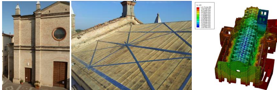
2012-14. Chiesa di Santa Caterina a Lucca, progettazione esecutiva del consolidamento sismico della cupola ellittica, del restauro conservativo delle strutture lignee di copertura della Chiesa. Committente: Ministero per i Beni e le Attività Culturali-Direzione Regionale per i Beni Culturali e Paesaggistici della Toscana
