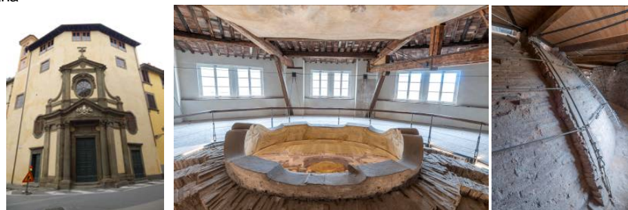
2012-14. Chiesa di Santa Caterina a Lucca, progettazione esecutiva del consolidamento sismico della cupola ellittica, del restauro conservativo delle strutture lignee di copertura della Chiesa. Committente: Ministero per i Beni e le Attività Culturali-Direzione Regionale per i Beni Culturali e Paesaggistici della Toscana
